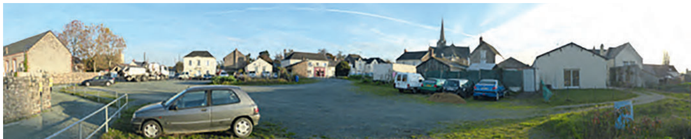
Site du Lavoir vu depuis la rue des Arts, point central du projet d'aménagement du centre-bourg de Mésanger Source : CAUE44, étude 2018
